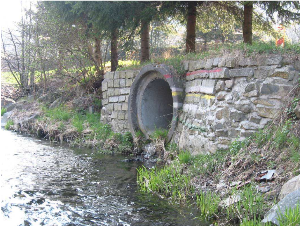
Obrázek 1. Měrný profil ve Vlčovicích pod kostelem (foto: autor, 2009)
